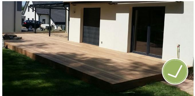
Niveau du platelage et du plancher intérieur identique.
