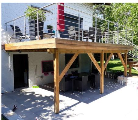
La terrasse est alors un ensemble indépendant avec une hauteur qui peut varier de 5 cm à 60 cm. Il est important que le bois de la structure soit isolé du sol par des plots ou des cales en PVC.
