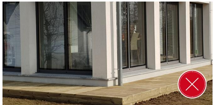
Niveau du platelage plus bas que le plancher intérieur.
