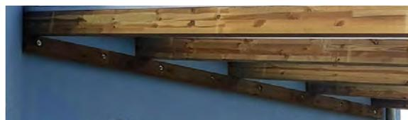
**Poutre porteuse** : éléments de support pour le solivage et les éléments de toiture. Reliée aux poteaux par un épaulement.
